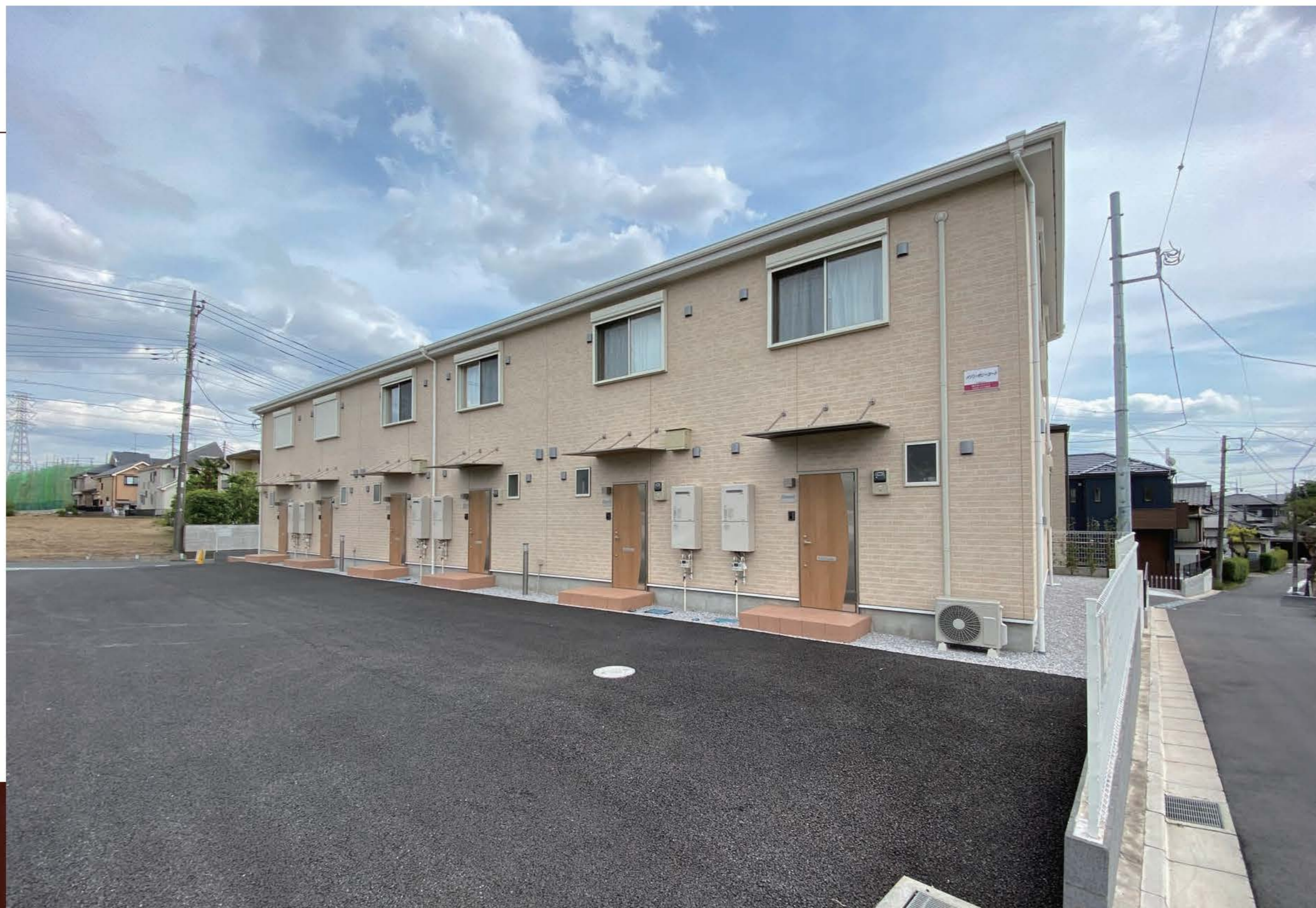
施工実績：富士見市 集合住宅
