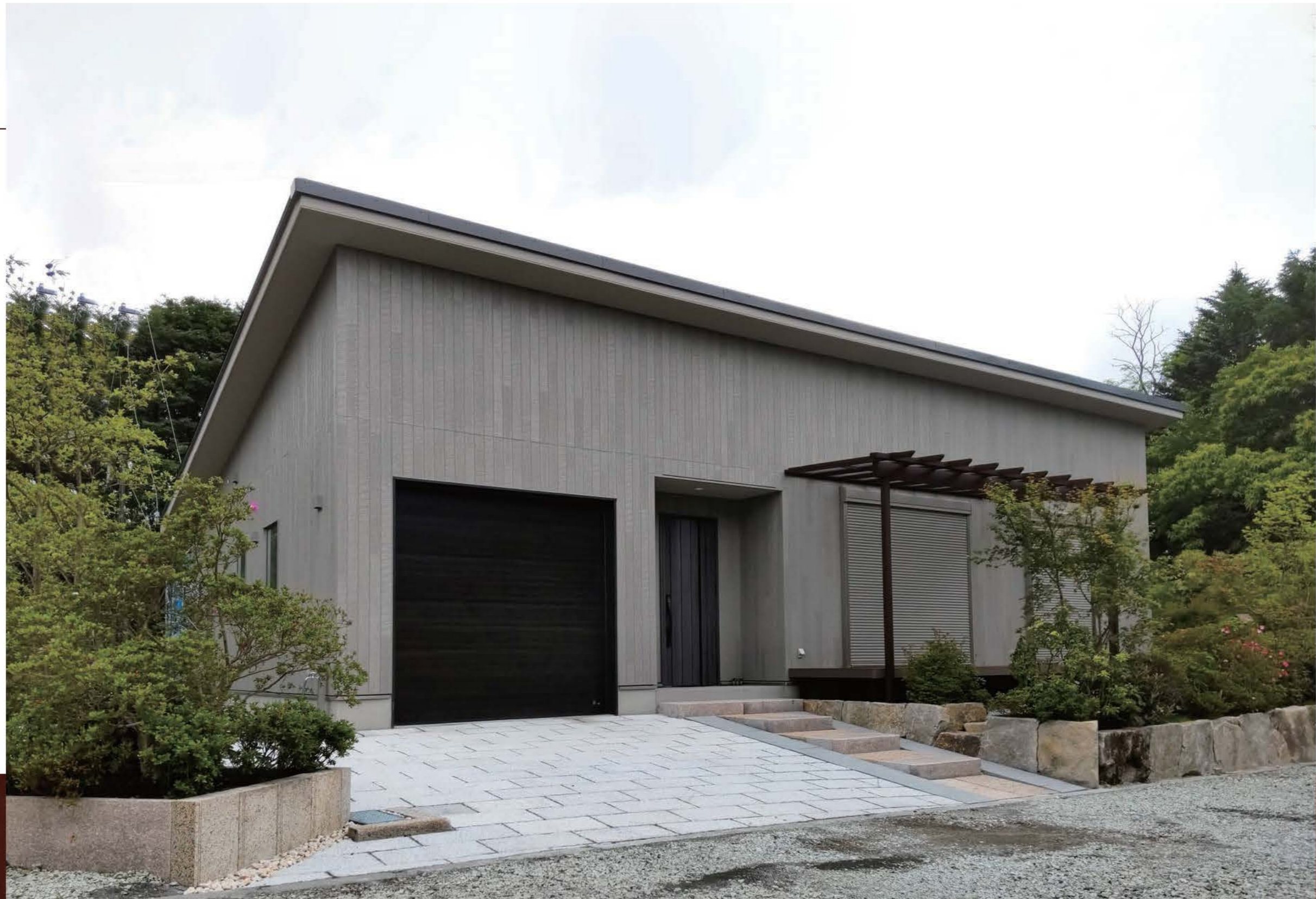
施工実績：軽井沢町 邸
